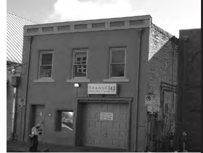
Paggi Blacksmith Shop
